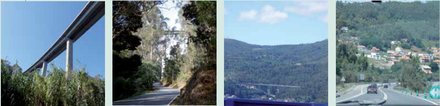
FIGURA 7. AMPLIACIÓN DEL CORREDOR DEL MORRAZO: LOS VIADUCTOS DEL CORREDOR Nivel de impacto de las infraestructuras del Corredor del Morrazo en el territorio, potenciador de “riesgos”.
