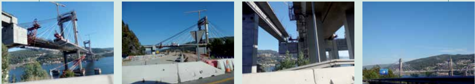
FIGURA 6 . AMPLIACIÓN DEL CORREDOR DEL MORRAZO: EL PUENTE DE RANDE Nivel de impacto de las infraestructuras del Corredor del Morrazo en el territorio, potenciador de “riesgos”.
