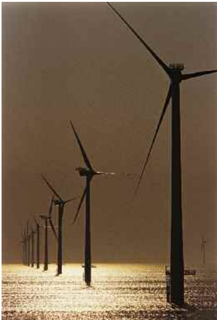
El parque eólico marino de Horns Rev, a 20 km de las costas de Dinamarca, está formado por 80 aerogeneradores que se elevan a 110 m de altura.
